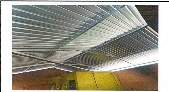
Foto 3: Finalización de cambio de estructura y láminas del techo de la cocina
