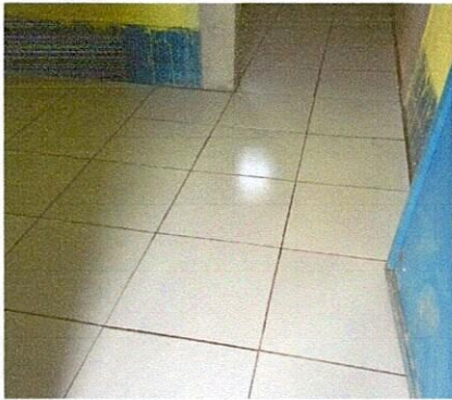
Foto 3: Finalización de colocación de piso cerámico en la dirección.
