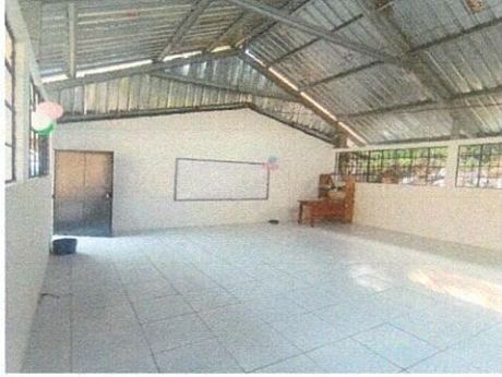
Foto 1: Finalización de colocación de piso cerámico en el aula nueva.
