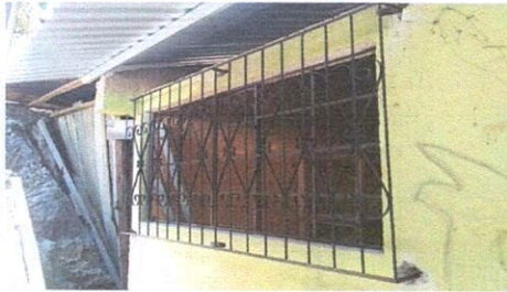
Foto 1: Finalización de instalación de una ventana y balcon en la cocina.
