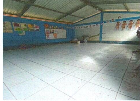
Foto 2: Finalización de instalación de piso cerámico en el aula de preprimaria.
