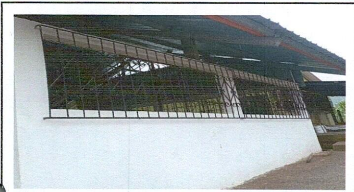
Foto1: Finalización de instalación de 6 balcones y 6 ventanas en esta clase
